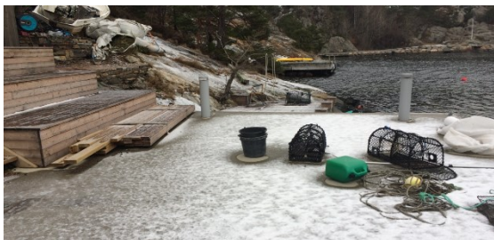
Foto 23.01.2019 – utbedring eksisterende brygge
