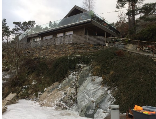
Foto 23.01.2019 – adkomst m/støttemur etc.
