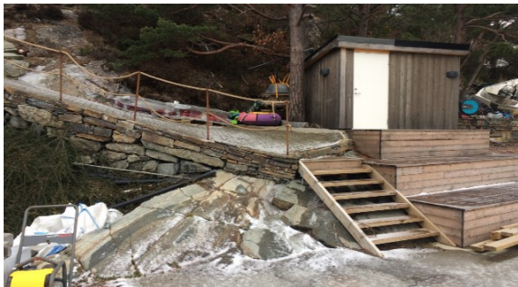
Foto 23.01.2019 - adkomst, trapp og sjøbod
