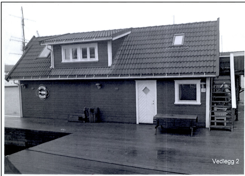
Utvendig trapp og to takvinduer
