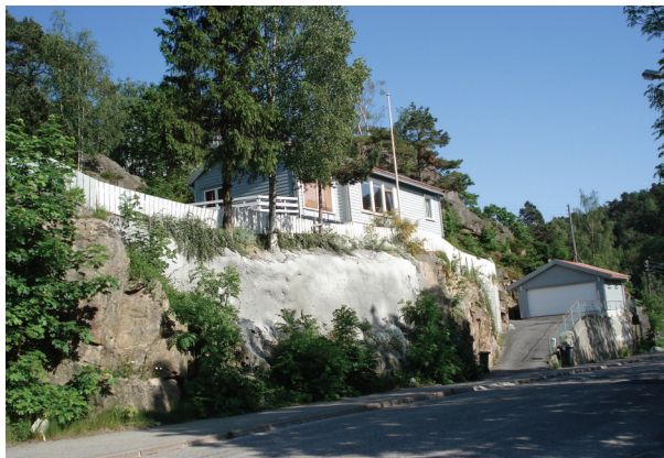
Vigeveien 1 sett fra nordvest
