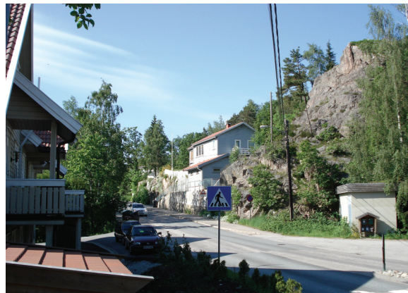
Vigeveien 1 sett fra sørvest
