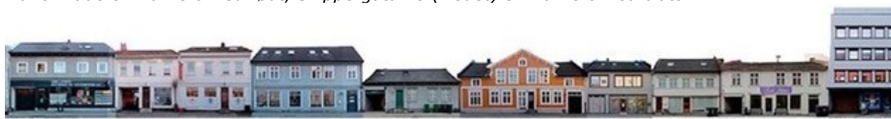
Den sammenhengende trehusrekken i Henrik Wergelands gate
