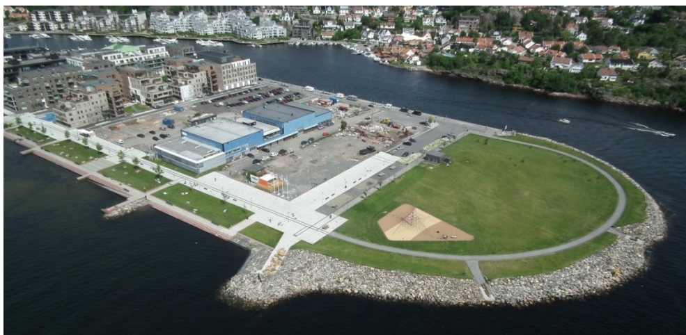
Foto som viser bølgebryteren ytterst på Tangen.
