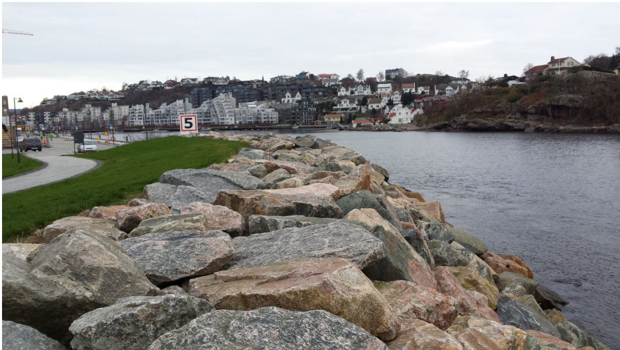
Foto som viser bølgebryteren ytterst på Tangen.
