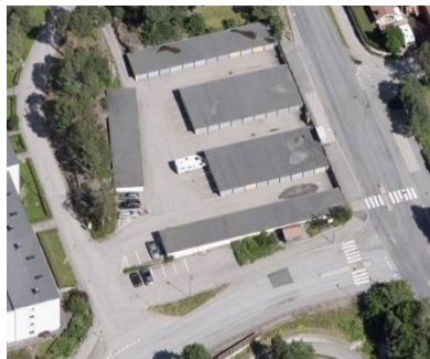
Garasjeanlegg i sør
