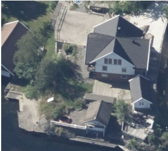
Bilde av eksisterende eiendom (Vavikbakken 14)
