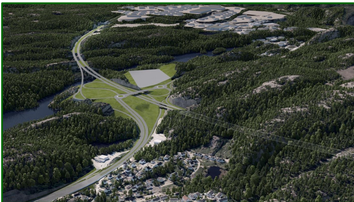
Figur 11. Kryss Breimyr anbefalt og akseptert korridor sett fra sør-øst.
