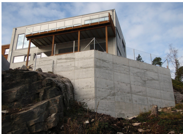
Forstøtningsmur som bygget
