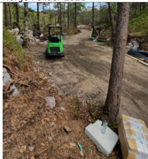
Bilde tatt på befaring 14.5.2020
