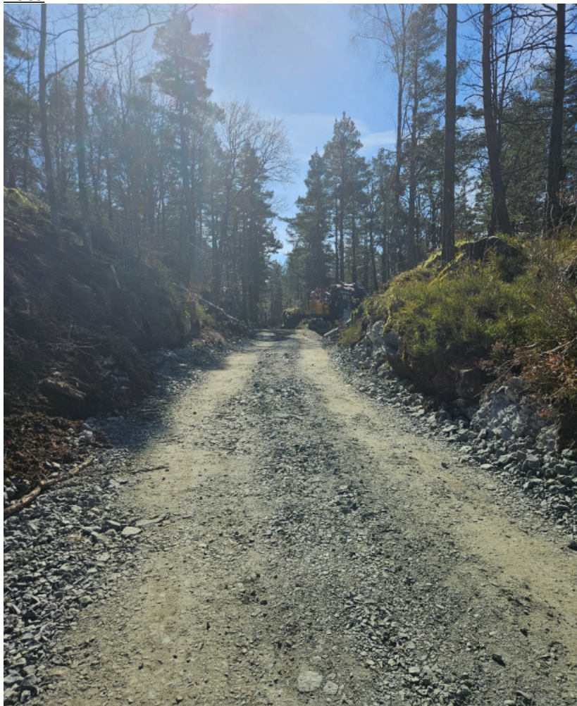
Figur 2 viser påbegynt anleggsvei. Kilde: ULOV-25/00883-2
