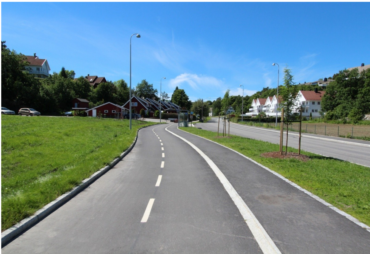
Bildet viser en ferdig parsell av ekspresssykkelvegen i Vågsbygd
