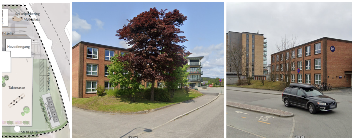
Figur 14: illustrasjonsplan til venstre og jordvollen med vegetasjon sett fra google streetview i midten og til høyre (mai 23 og apr. 22). Per jan. 25 er all vegetasjon fjernet med unntak av et tre.
