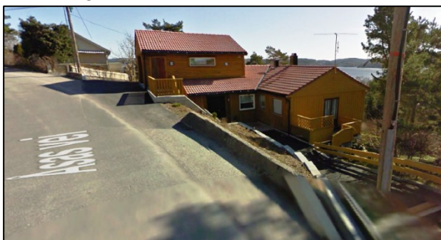
Åsas vei 8 – Påbygg fra 2008 – garasje med heis
