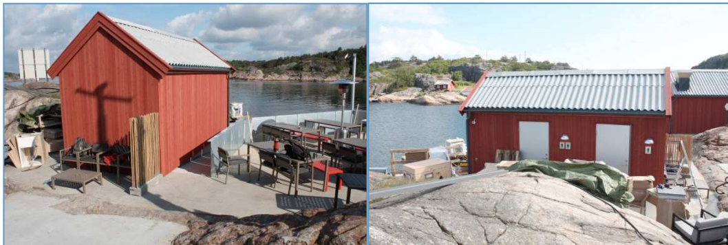
Figur 1 Bildene viser toalettet som er under oppføring på verftstomta
