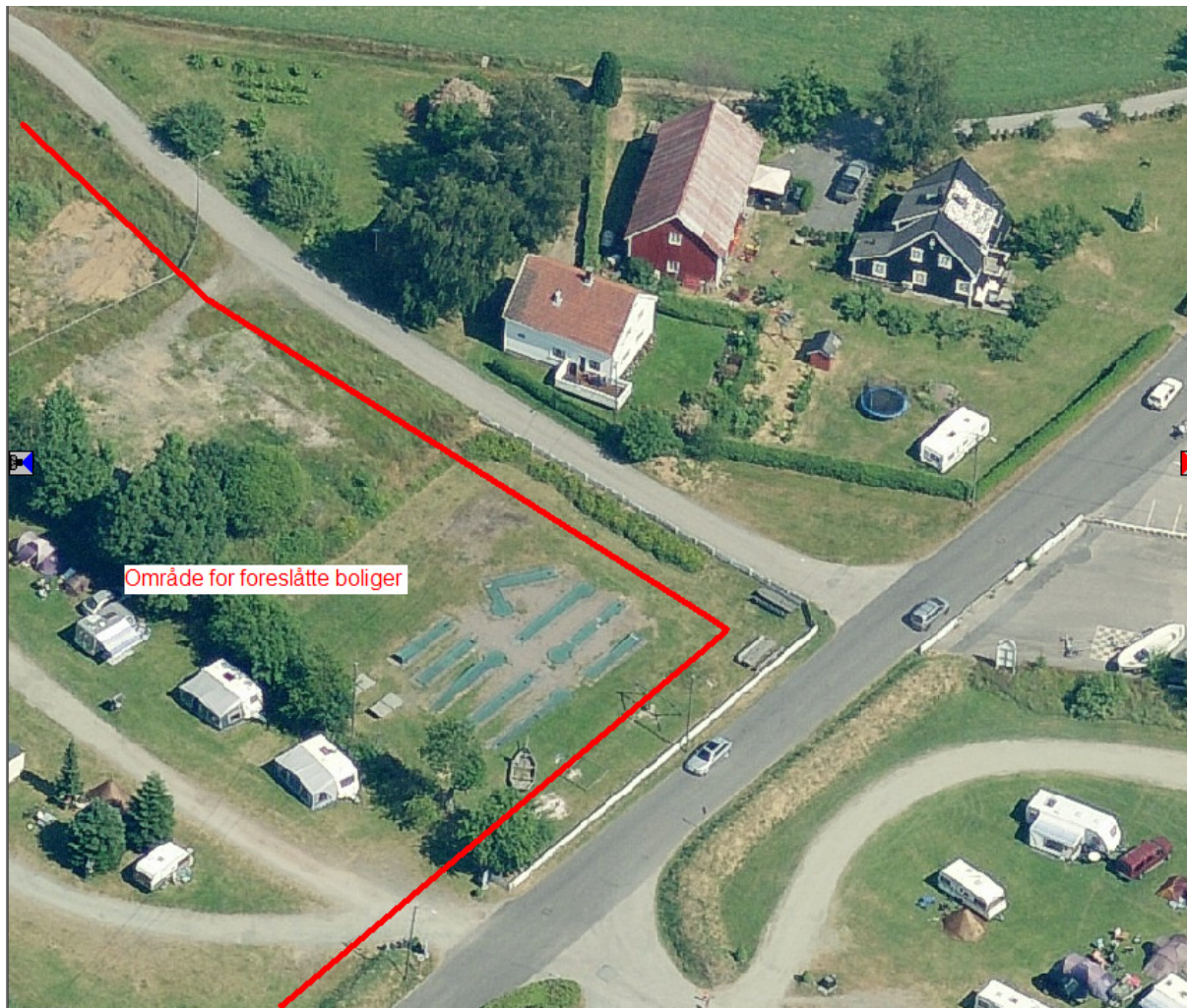
Bildet viser dagens situasjon sett fra vest. Nabohus er frittliggende gode solforhold og utsikt.
