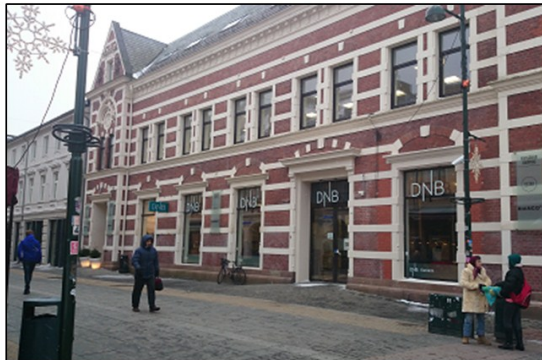
Godkjent skilting i 1. etasje ferdig montert
