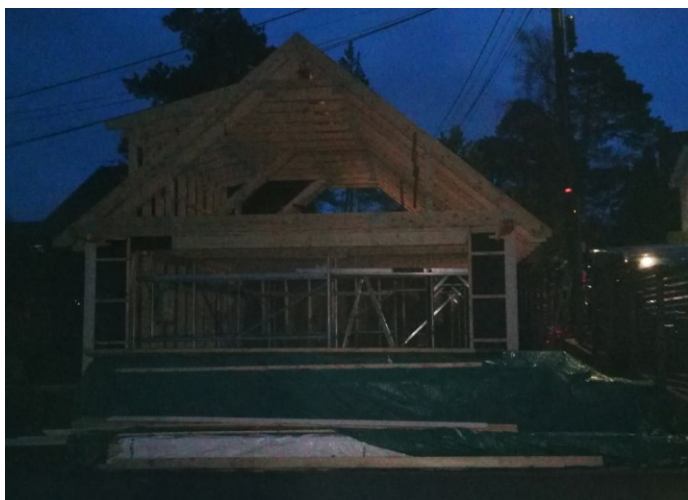
Fig. 3 - Bilde tatt av en byggesaksbehandler 17.3.2019
