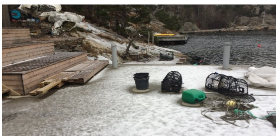
Foto 23.01.2019 – utbedring eksisterende brygge
