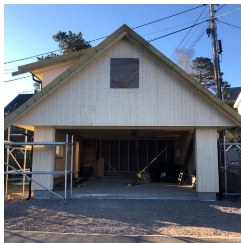
Fig. 4 - Bilde tatt fra befaring 8.4.2019
