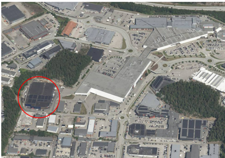
Figur 1 - Flyfoto - Barstølveien 19 markert med rød ring
