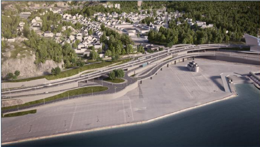
Figur 21: Krysset ved Arkivet. Havneområdet i forgrunnen. Arkivet og Samsen kulturhus bak sykkeleक्सpressvegen. Ny ferjeadkomst fra krysset ved Arkivet ned til vestre del av ferjehavna. SVV's illustrasjon
