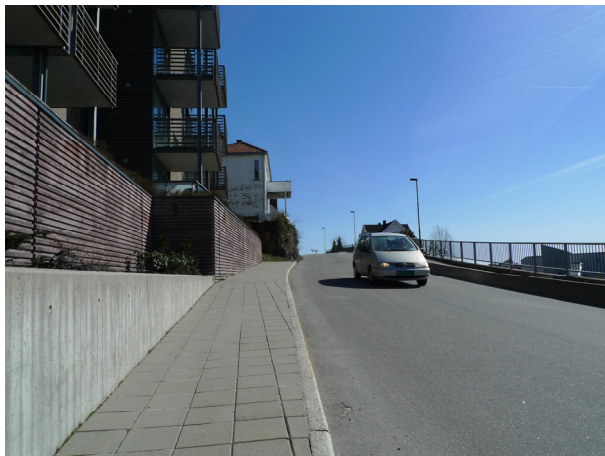
Ved Kuholmsveien 27. Eksisterende fortau skal forlenges frem til Kuholmsveien 37.
