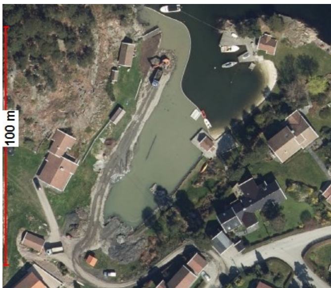
Ortofoto 2018 (viser at arbeidene er i gang)
