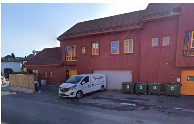
Byggets vestside, mot nord
