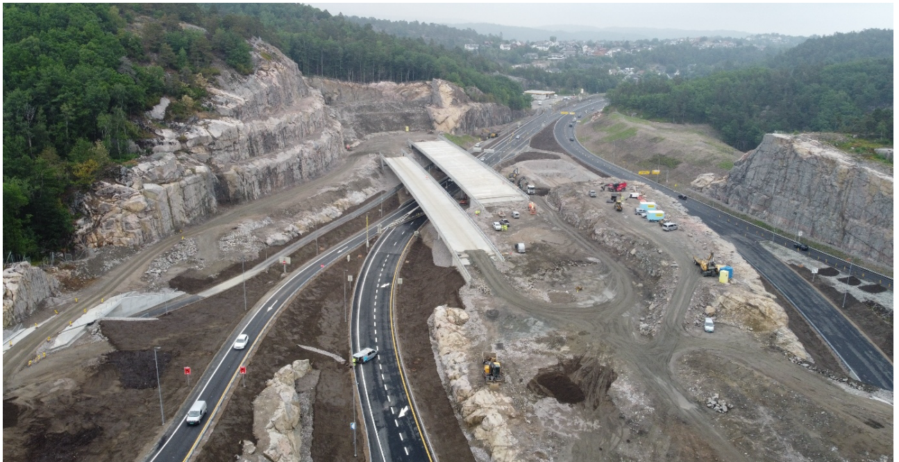
Dronefoto fra dagens kryss ved Grauthelleren med to broer som er anlagt og forskjæring for tunnel som er sprengt ut bak broene på bildet over.
