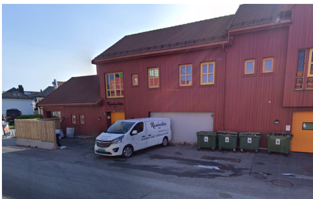
Byggets vestside, mot nord
