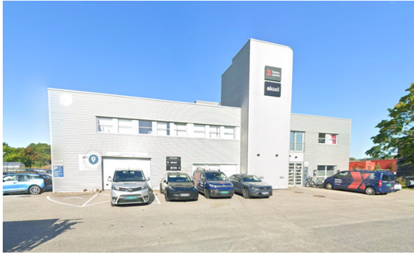
Eksisterende bygg sett i fra Industrigata
