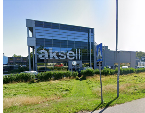
Eksisterende bygg sett i fra Østre ringvei
